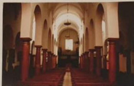
Coro de la Parroquia Mayor. Columnas realizadas en caliza nodulosa "Ammonítico Rosso" del Jurásico superior con presencia de ammonites.
