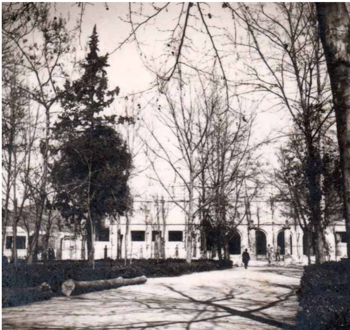
Perspectiva de la calle central del Paseo. Al fondo, los Grupos aún en construcción.
